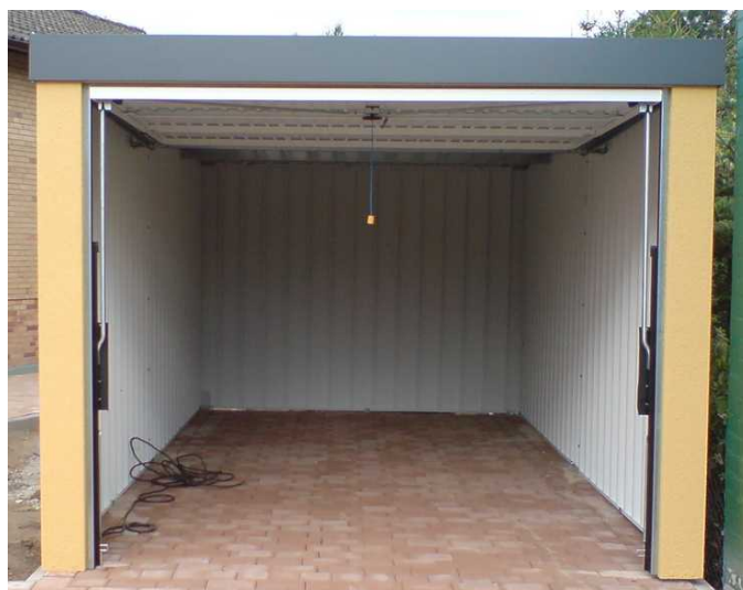
Brandschutz in einer Stahlfertiggarage von Garagenrampe.de
