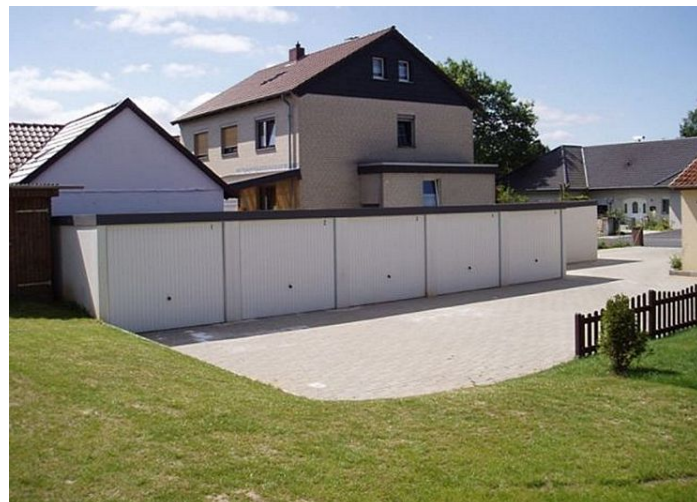
Elektroleitungen für Exklusiv-Garagen
