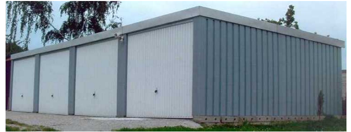
Garagenhöfe großzügig bemessen mit Garagenrampe.de
