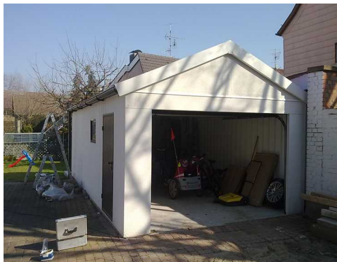
Korrekturer Brandschutz mindert die Gefahr von Garagenbränden
