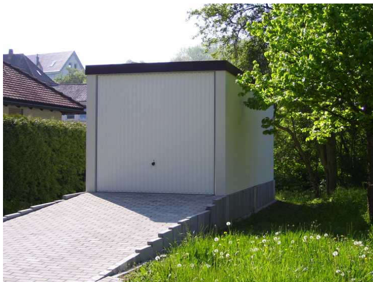
Bei Starkregen und Wasserrohrbruch vor Hochwasser geschützt
