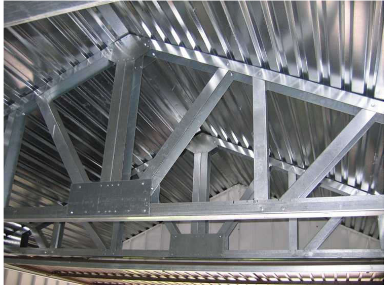
Unterkonstruktion eines Garagensatteldaches von Garagenrampe
