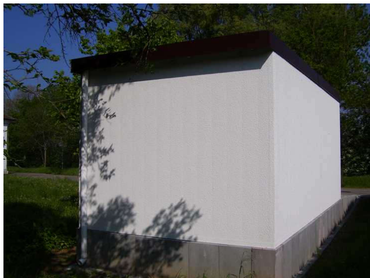
Mit Garagenrampe.de das Garagenfundament gestalten
