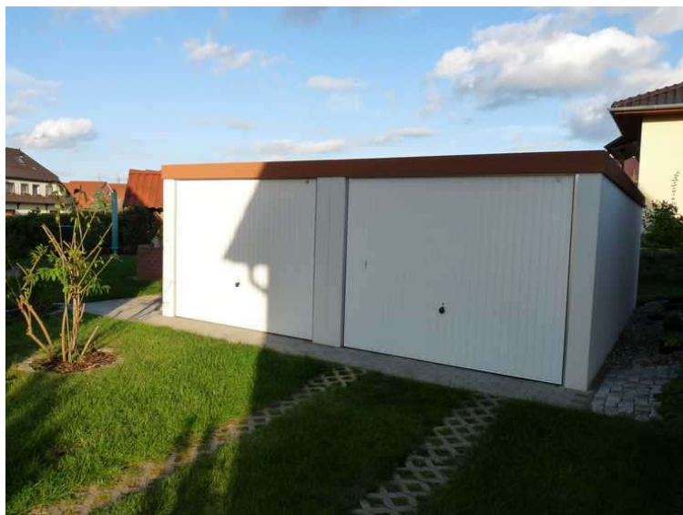
Mehr als nur Garagen mit Garagenrampe.de
