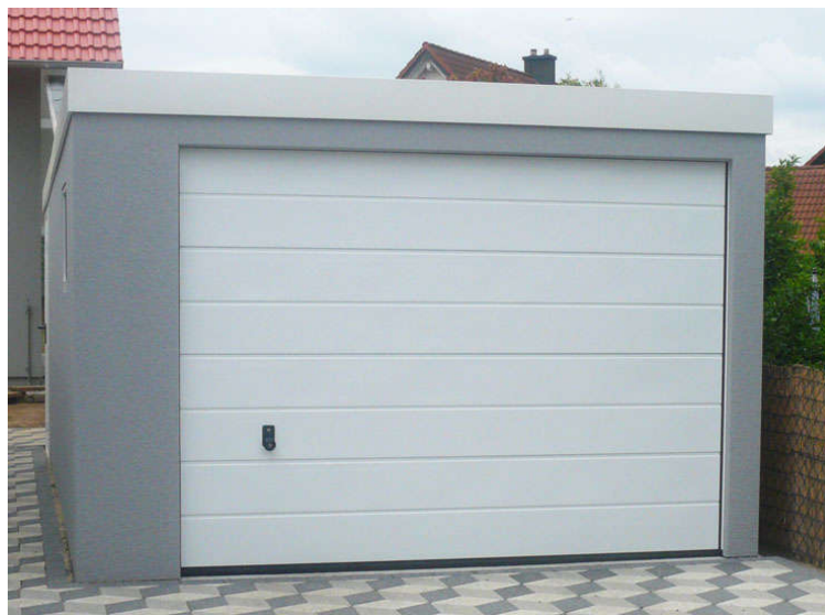
Gut belüftete Exklusiv-Garage
