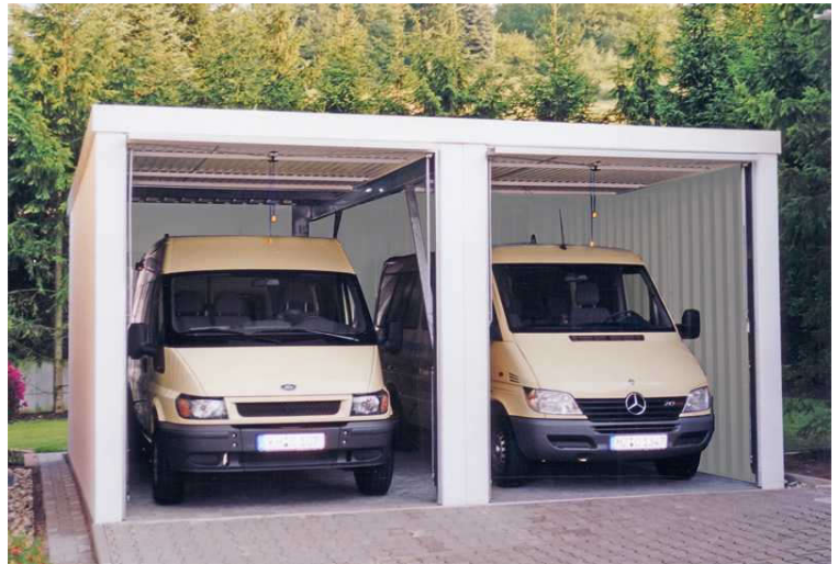
Viel Platz in MC-Garagen auch für Rettungsfahrzeuge
