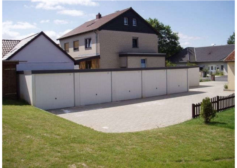
Harmonie zu Hauptgebäuden und Umfeld mit Exklusiv-Garagen
