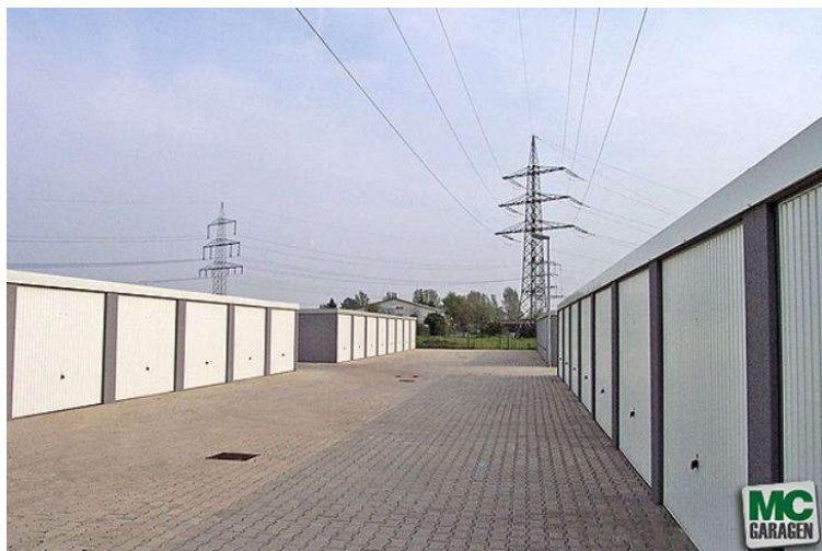
Beispiel eines Garagenhofes mit 24 MC-Garagen
