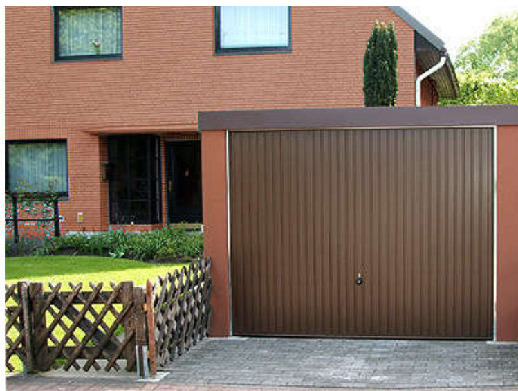
Für Brandschutz in einer Exklusiv-Garage sorgen
