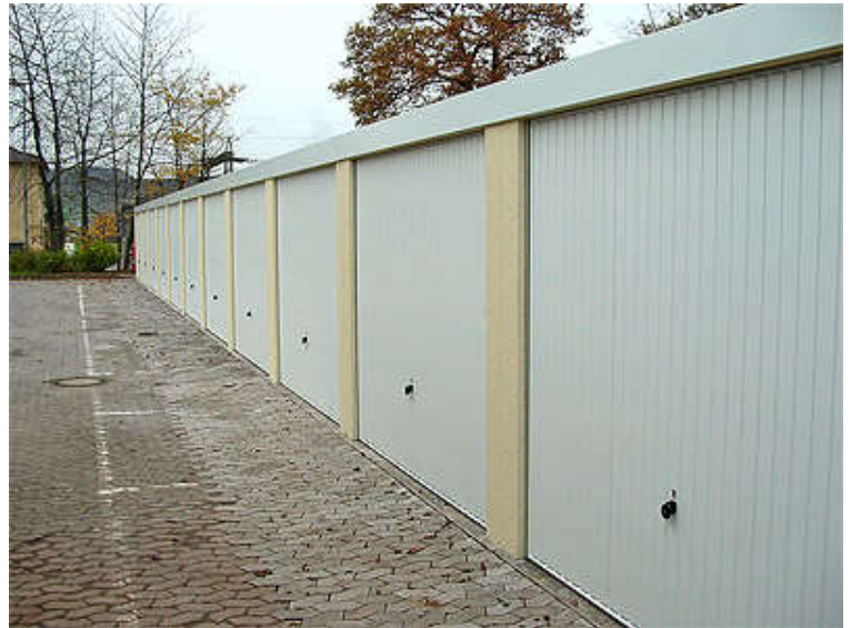
Exklusiv-Garagen, wo früher gemauerte Garagen standen
