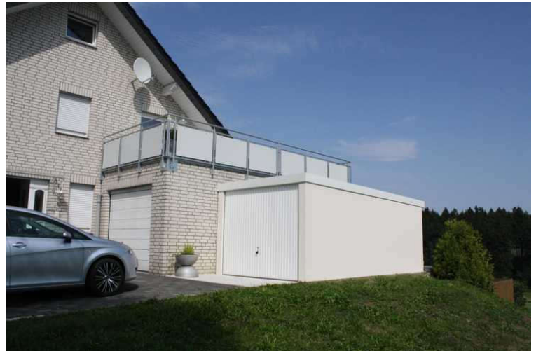
Zusätzlicher Garagenraum mit Garagenrampe.de
