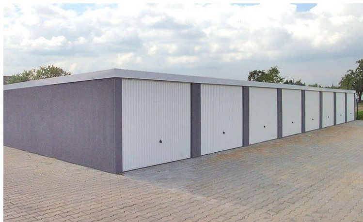
Raum für Kunst an Wänden und auf Dächern von MC-Garagen
