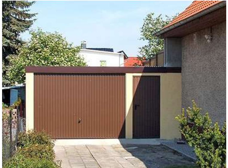
Abluftschlitz rund um das Garagendach in Exklusiv-Garagen verhindert Hitzestau
