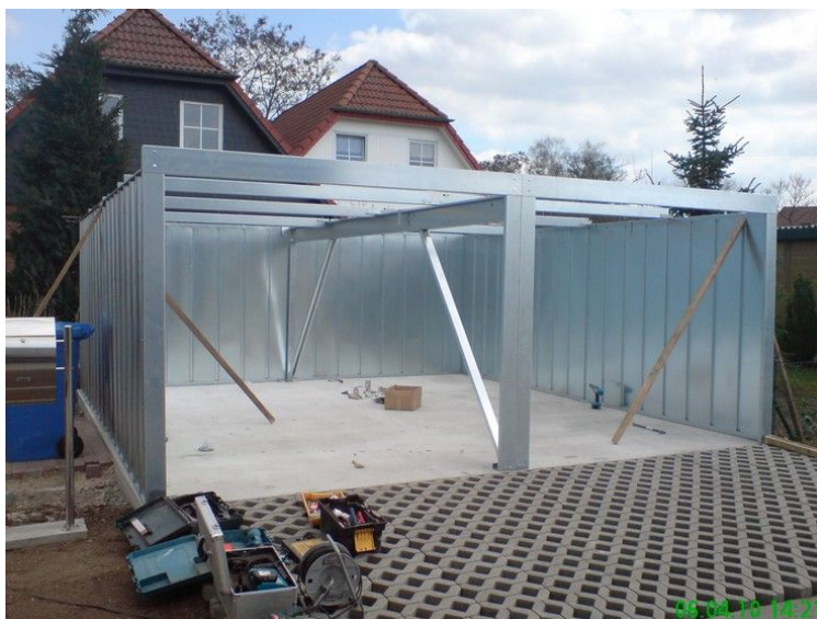
Garagenrampe.de baut die Doppelgarage an einem Arbeitstag auf.
