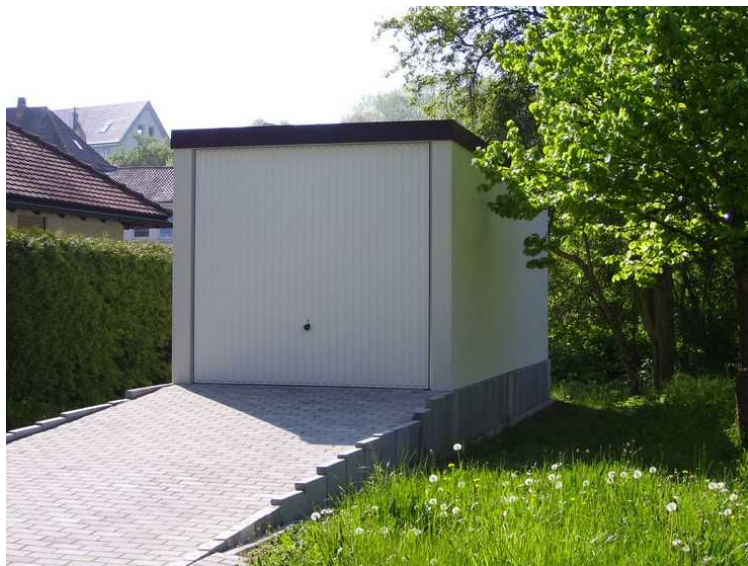
Vor Hochwasser geschützte Garage durch erhöhtes Garagenfundament
