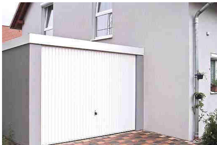
MC-Garagen: gut belüftet, weil von der Sonne beschienen
