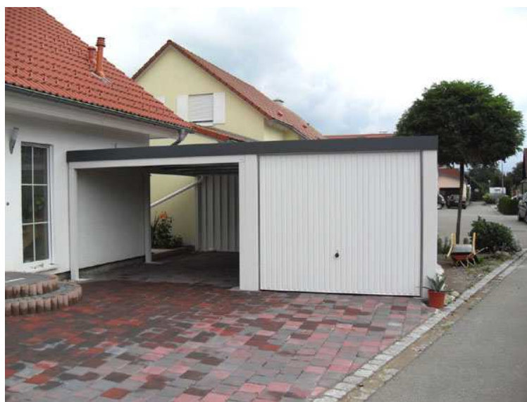
Überdachter Raum von Exklusiv-Garagen für Autos und mehr
