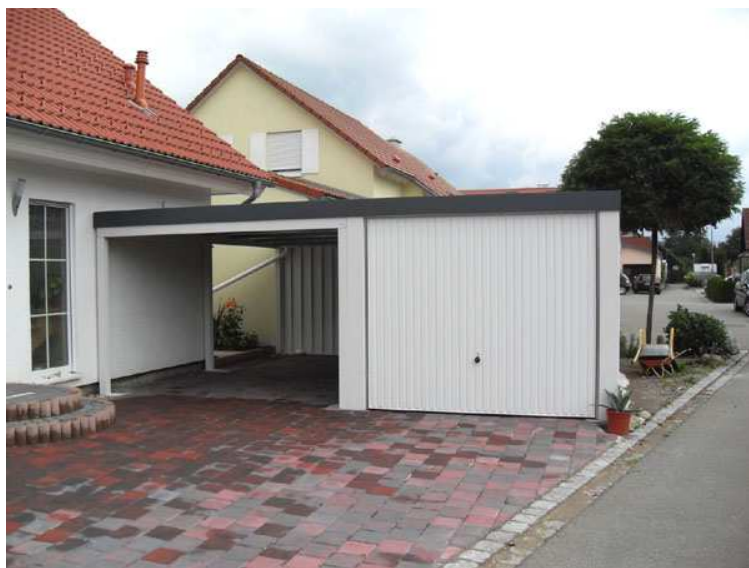
Überdachter Raum von Exklusiv-Garagen für Autos und mehr
