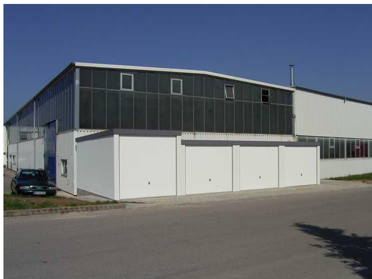
Baulücken geschmackvoll nach Bedarf füllen mit Garagenrampe.de
