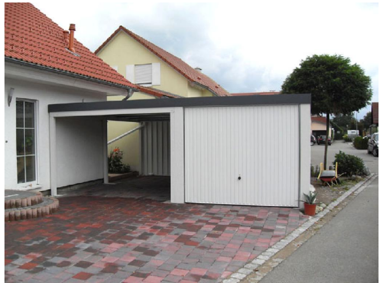
Exklusiv-Garage und Carport: Nutzen nach Bedarf
