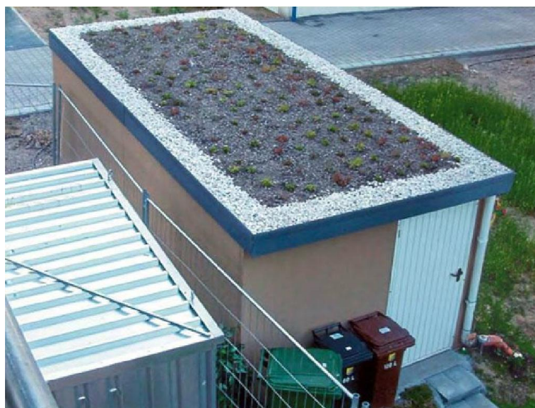
Garagenbau vom Feinsten mit Fallrohr und Garagendach: Exklusiv-Garagen
