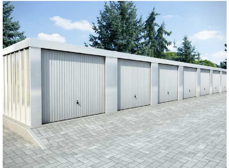
Hochwertiger Ersatz für alte Garagenhöfe von Garagenrampe
