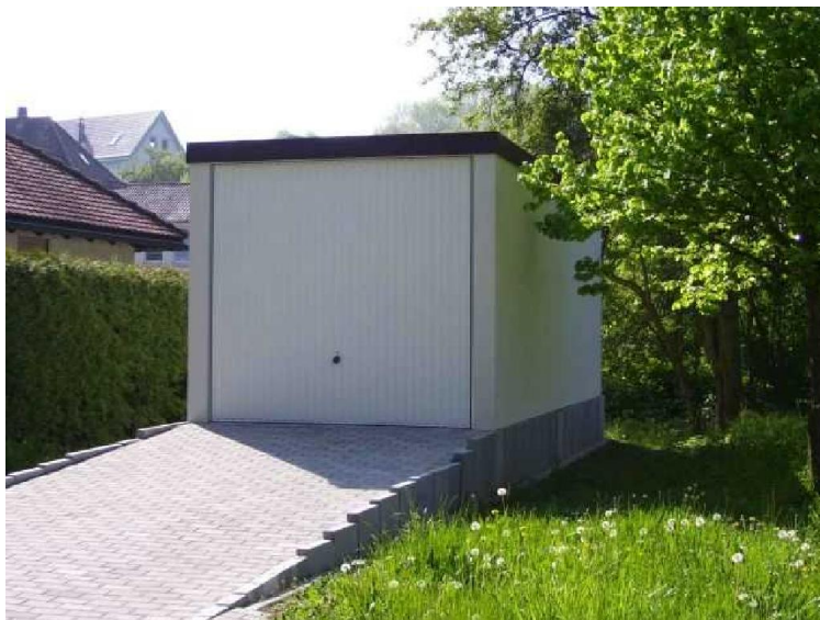
Erhöhte Lage für eine Exklusiv-Garage als Hochwasserschutz
