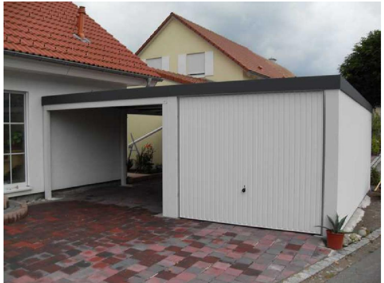
Garagenrampe: Garage und Carport auf dem Stand der Technik
