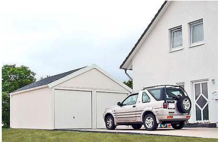
Mit dem Fundamentaushub das Garagenumfeld gestalten
