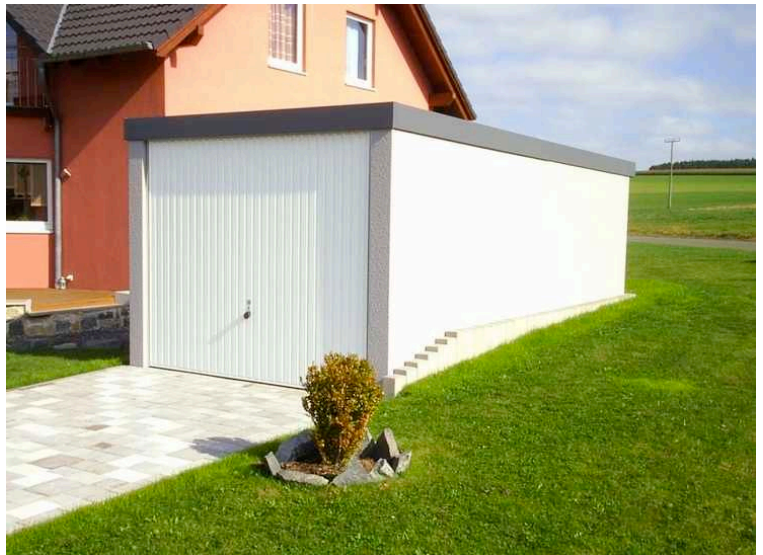
Bestens gegen Einbrüche gesichert: Exklusiv-Garagen
