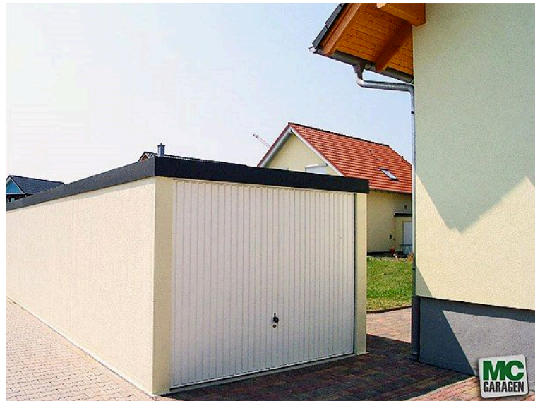
MC-Garagen: Garagen-Hopper müssen draußen bleiben
