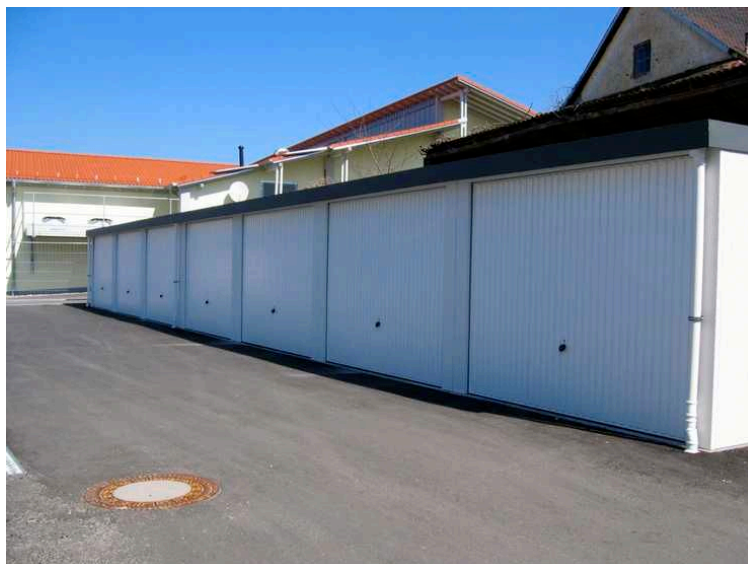
Garagenrampe.de: Ein sauberes Umfeld ist angenehm in Garagenhöfen
