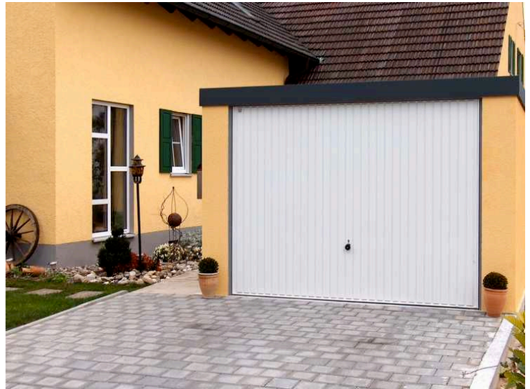
Garagenrampe mit Hörmann Garagentorantrieben
