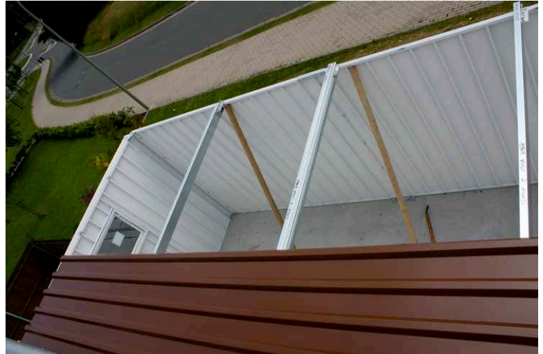
Gute Belüftung ohne zusätzlichen Aufwand: Garagenrampe.de
