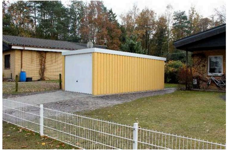
Freiraum für Bedarf: Garagen mit Garagenrampe
