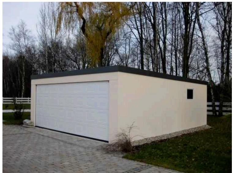
Optimaler Lagerraum mit einer Exklusiv-Garage
