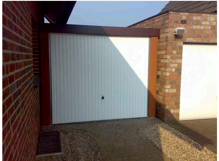
Für jede Baulücke die passende Lösung: Garagenrampe
