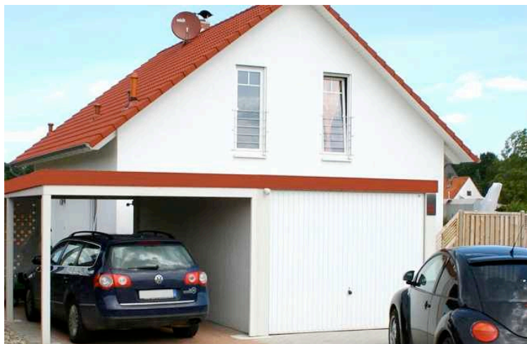
Immer vornedran im Garagenbau mit MC-Garagen
