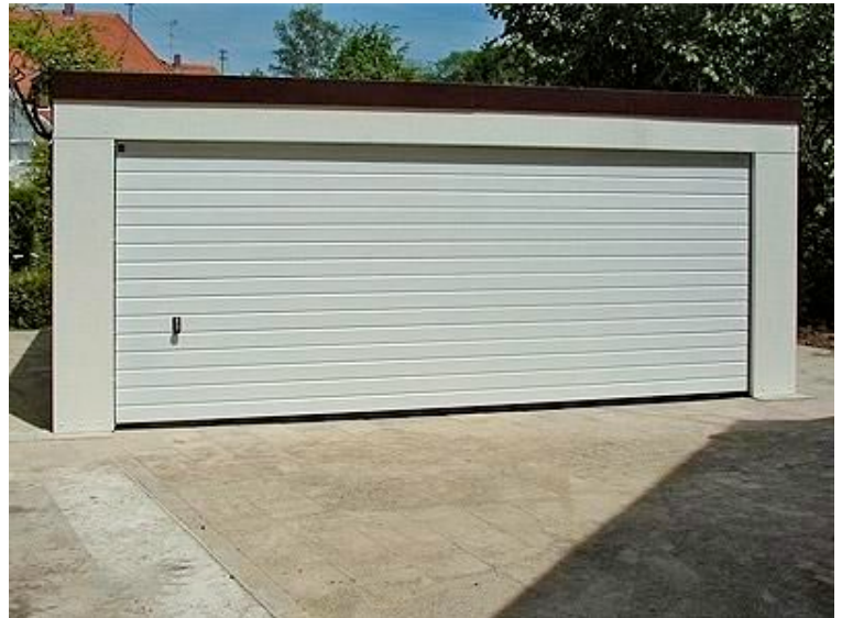
Elektromobil mit 230 Volt in einer Exklusiv-Garage
