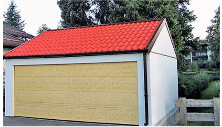
Mit der Energie der aufgehenden Sonne: MC-Garagen
