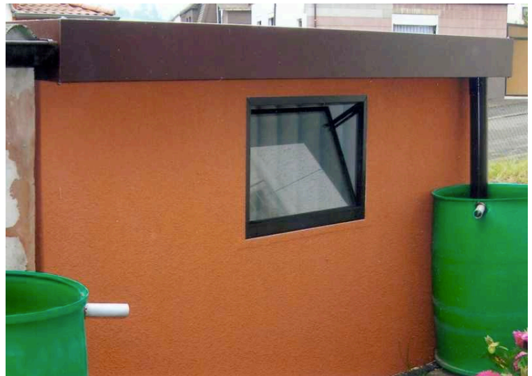
Optimal für Autos und als Lager: Garagenrampe.de
