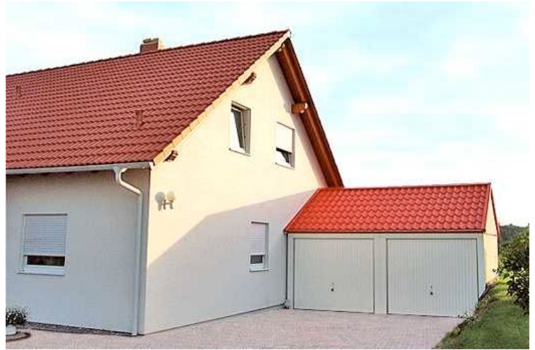
Zufahrtswege zu MC-Garagen sind Privatgrund
