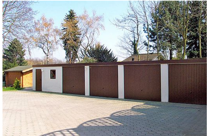
Passend und individuell bauen mit MC-Garagen
