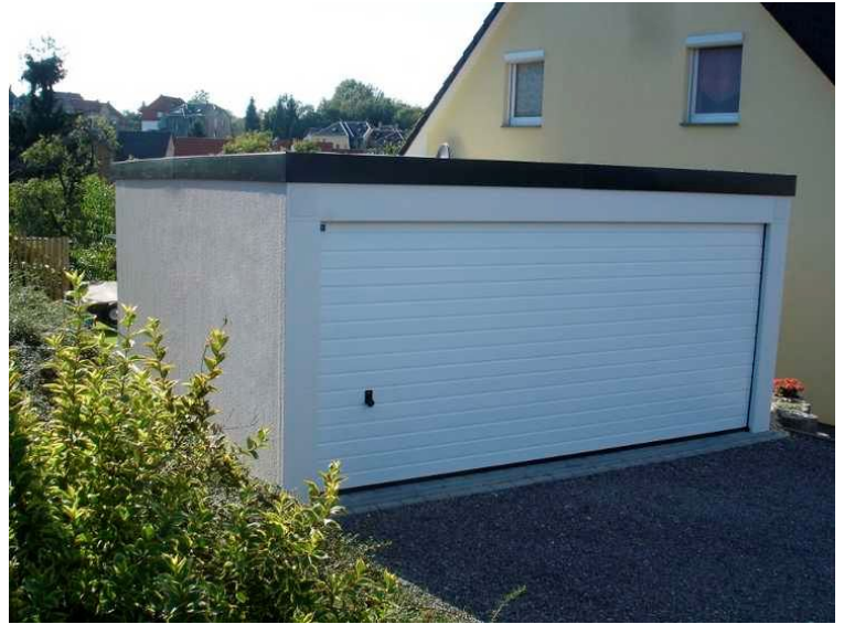
Garagenrampe: Garagentor mit Torantrieb
