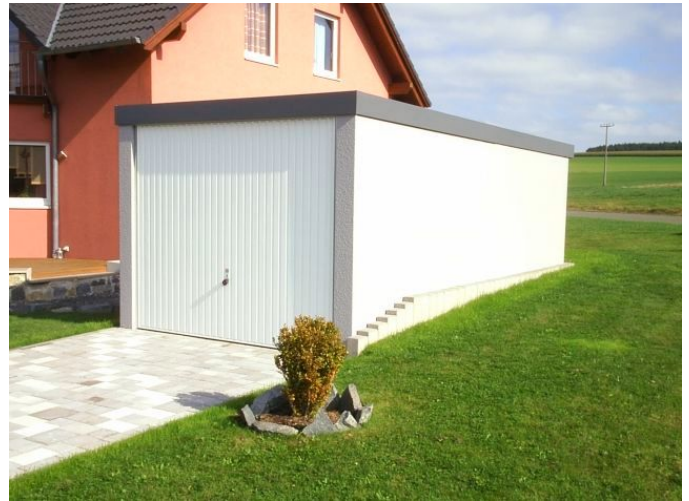
Exklusiv-Garagen: Schutz vor Oberflächenwasser in Hanglagen
