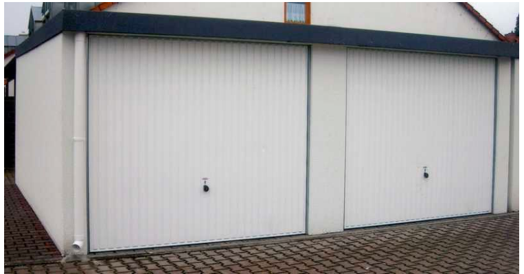
Zwei Garagen für ein Zweifamilienhaus von Garagenrampe
