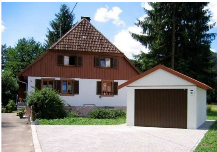
Großzügig gestalteter Zufahrtsweg zu einer Exklusiv-Garage
