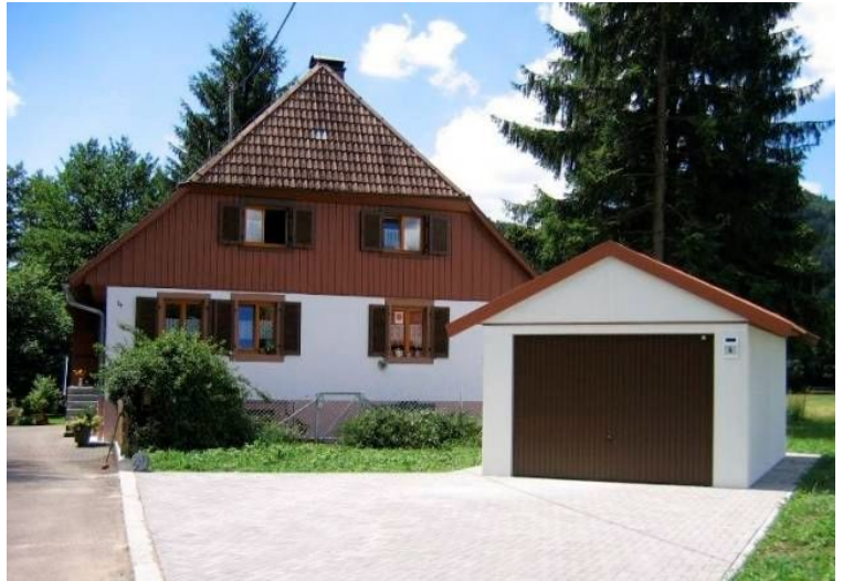
Großzügig gestalteter Zufahrtsweg zu einer Exklusiv-Garage
