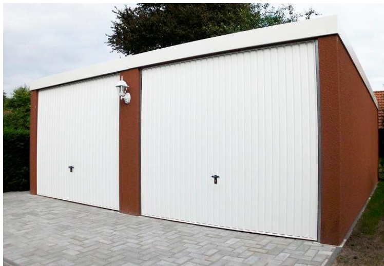
Sinnvoll gefüllte Baulücke mit Garagenrampe.de
