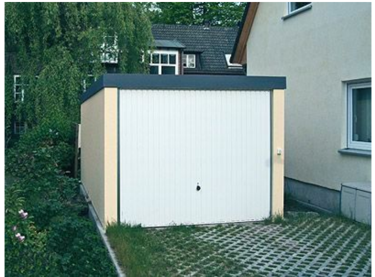
Mit Rücksicht auf die Nachbarn bauen
