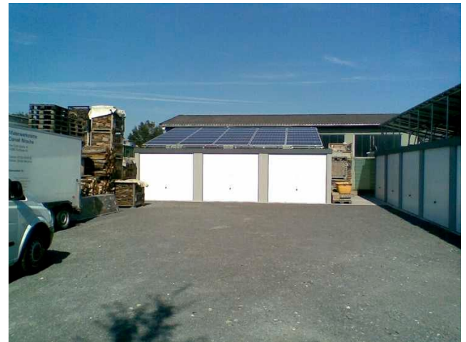
Garagen und Wohnungen getrennt vermieten
