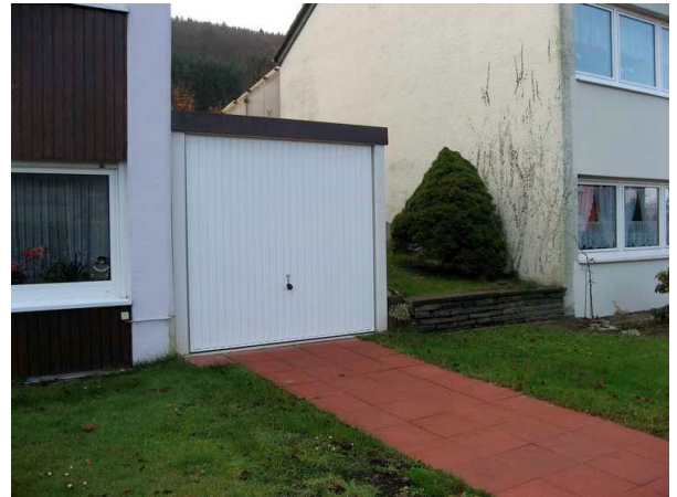
Passend eingefügte Garagen mit Garagenrampe
